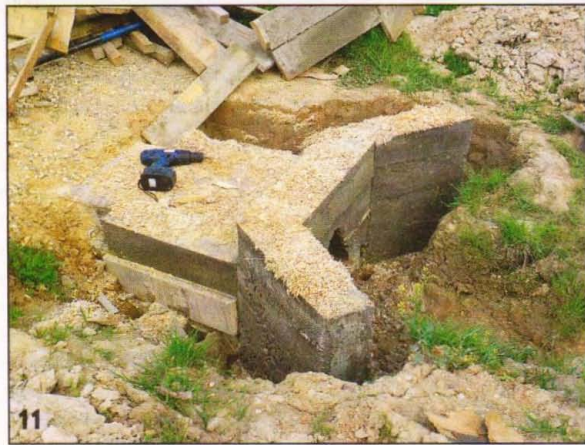
Сверху конструкцию засыпали опилками и поливали водой, чтобы бетон не пересыхал.
