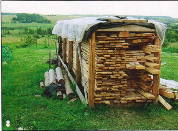
В последнюю очередь досками для чёрного пола заполнили оставленный ранее проход.
