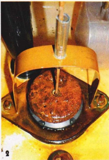
2 Устанавливаем сверху на «грушу» металлический диск. Этот груз позволяет и частично сливать воду из бачка.
