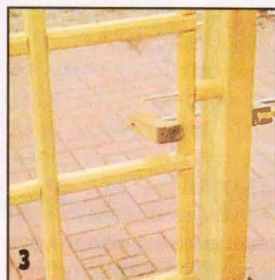
Чтобы вставить готовые решётки между стойками, возможно придётся уменьшить ширину решётки на один ряд ячеек. Для этого используют мелкозубую ножовку или электролобзик.
