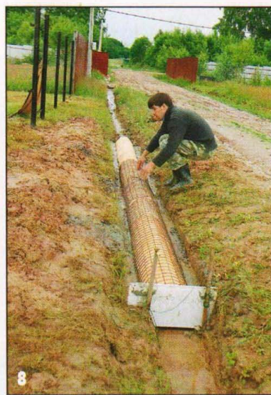
При установке арматуры свода надо было обеспечить зазор между сеткой и фанерной опалубкой.
