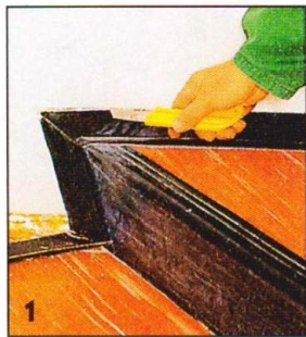
1 Обои, чтобы случайно их не повредить при удалении плинтусов, надрезают, проводя ножом по краю плинтуса как по направляющей.
