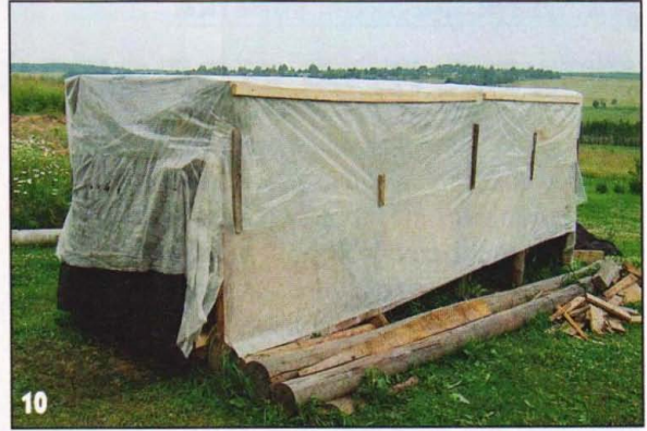
С трёх сторон навес затянули укрывным материалом до «пола», оставив только продухи снизу. Укрывной материал хорошо пропускает пар, но не даёт дождю, даже косому, мочить доски. Кроме того, укрывной материал не даёт конденсату скапливаться на нижней стороне кровли из полиэтиленовой плёнки.
