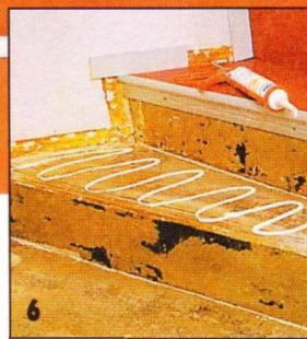
6 Выкроенные элементы облицовки крепят к ступеням на монтажном клее, который обильно наносят змейкой на проступь.
