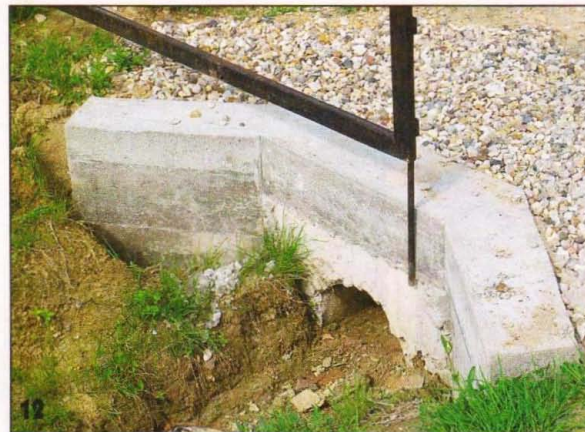
Результат работы мы посчитали удовлетворительным! Тем более, что впоследствии труба выдержала вес гружёного КАМАЗа.
