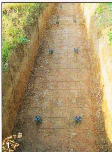
Арматурную сетку в отрытую траншею устанавливали на пластиковые «стульчики», чтобы при заливке бетона сетка не упала на землю.
