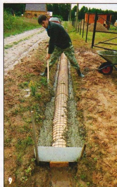
На заливку свода ушло несколько тачек бетона.
